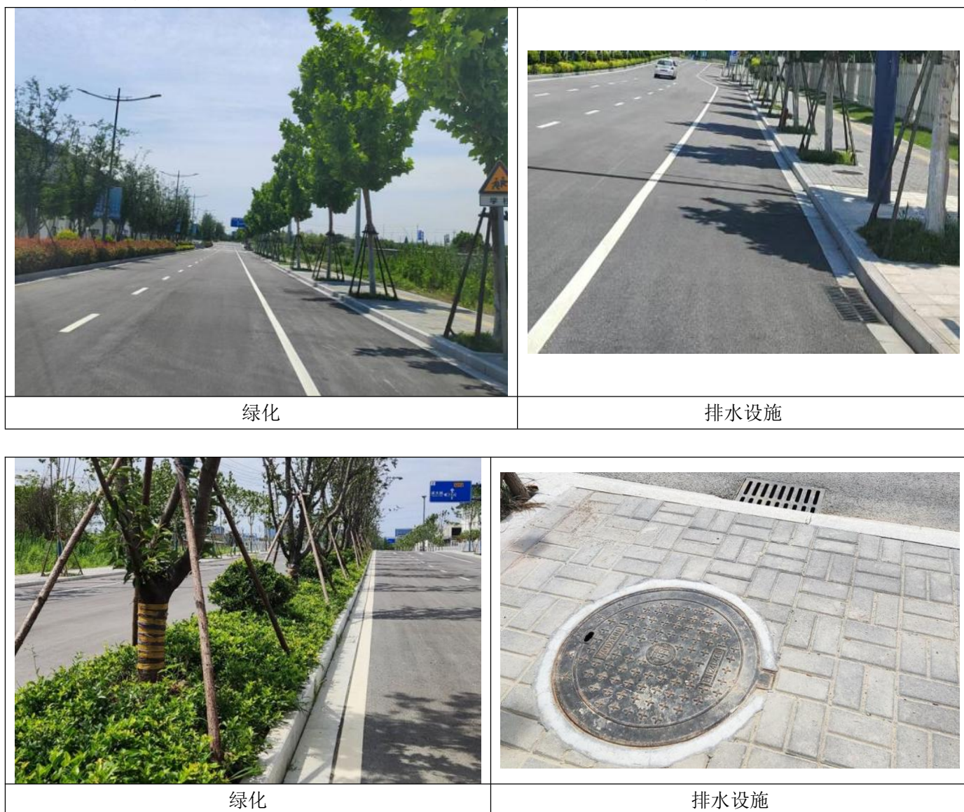
图 5.3-1 道路排水及绿化情况
