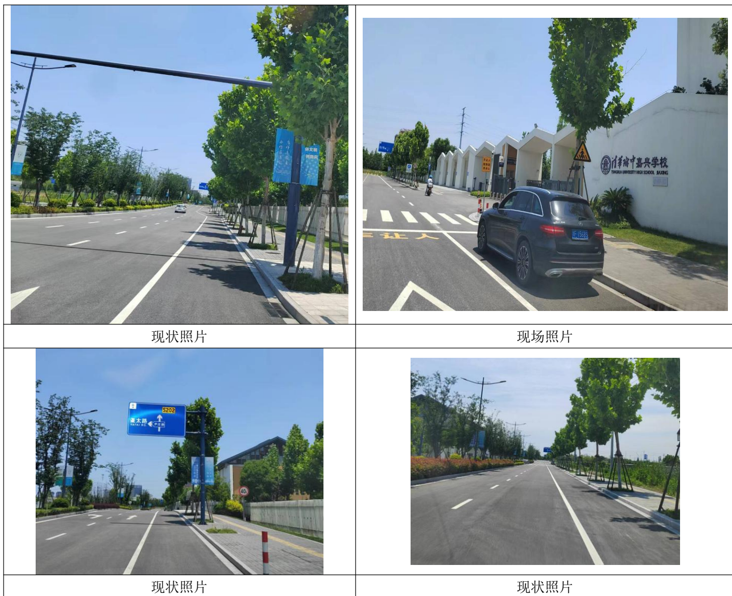
图 5.2-1 施工场地恢复情况
